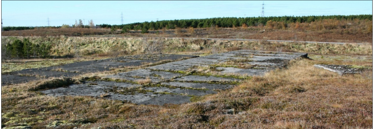
Mynd 202. Braggagrunnur (0-11) nær og lítill sökkull norðaustan við hann. Fjær er grunnur (0-12), horft til vesturs að Hafravatnsvegi.
