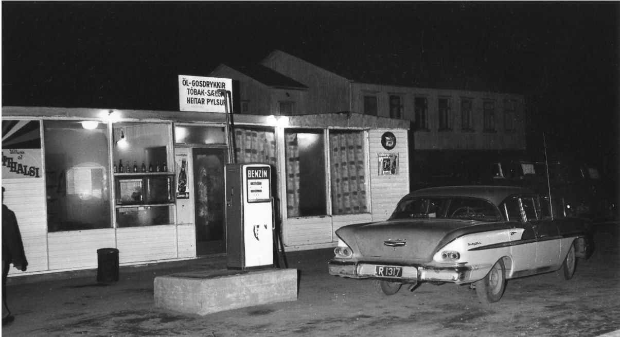
Mynd 178. Bensínsjoppa á Geithálsi 1963 (0-2), yngra húsið í bakgrunni sem var byggt 1940. 180
