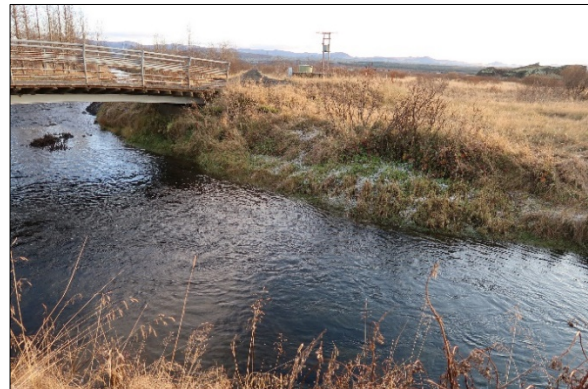
Mynd 145. Brúarstæði (213-78) yfir Bugðu sunnanmegin, horft til suðurs.
