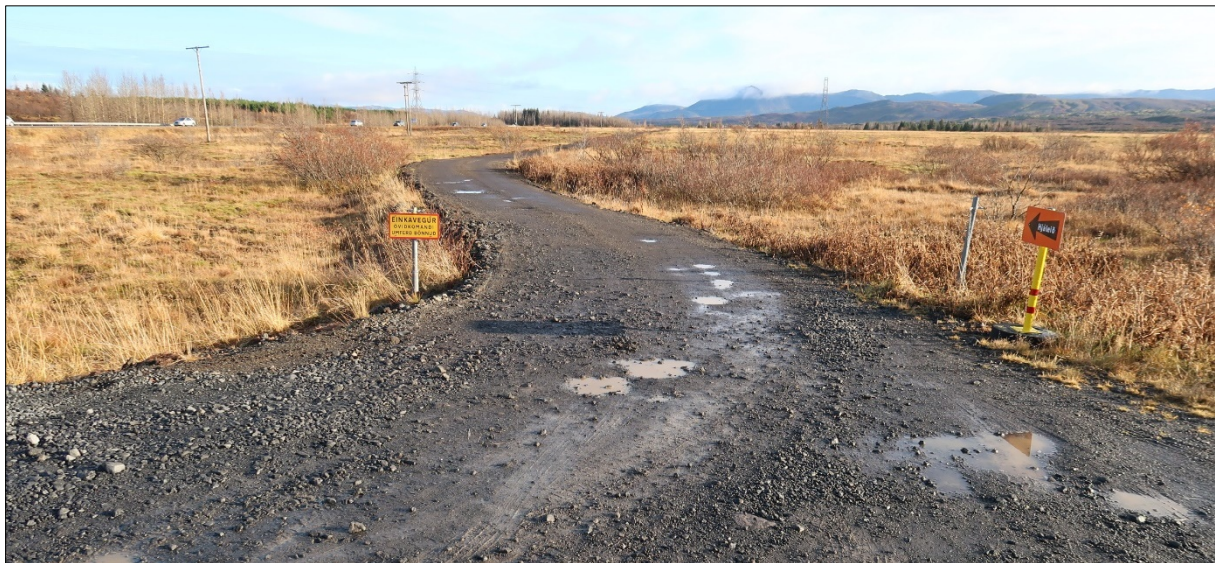
Mynd 135. Vegur (213-75), horft til austurs frá Heiðmerkurvegi.
