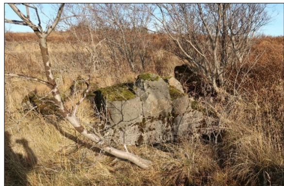
Mynd 209. Mosavaxin steinsteypa og samlímdir steinar úr brúarstöpli brúarinnar (0-21), horft til norðausturs.
